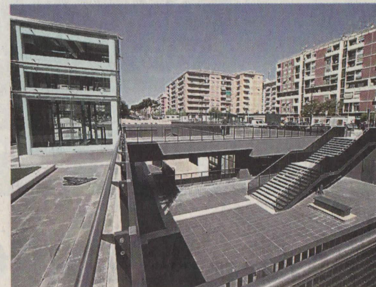
La piazza ipogea della stazione Malatesta (foto ANSA)
